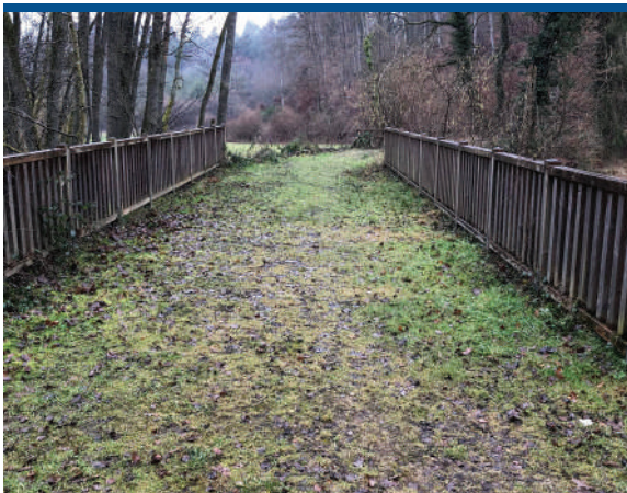
Mul_78: Grasbewachsene Holzbrücke
