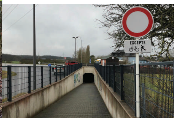
Mul_95: Unterführung in Stegen
