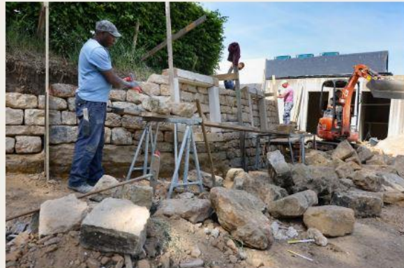
Un mur de pierres sèches en construction.
